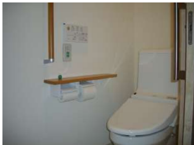
【特別室トイレ】
