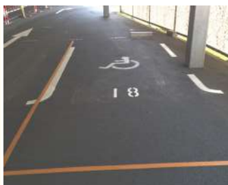
↓第2駐車場 お体の不自由な方用駐車場
